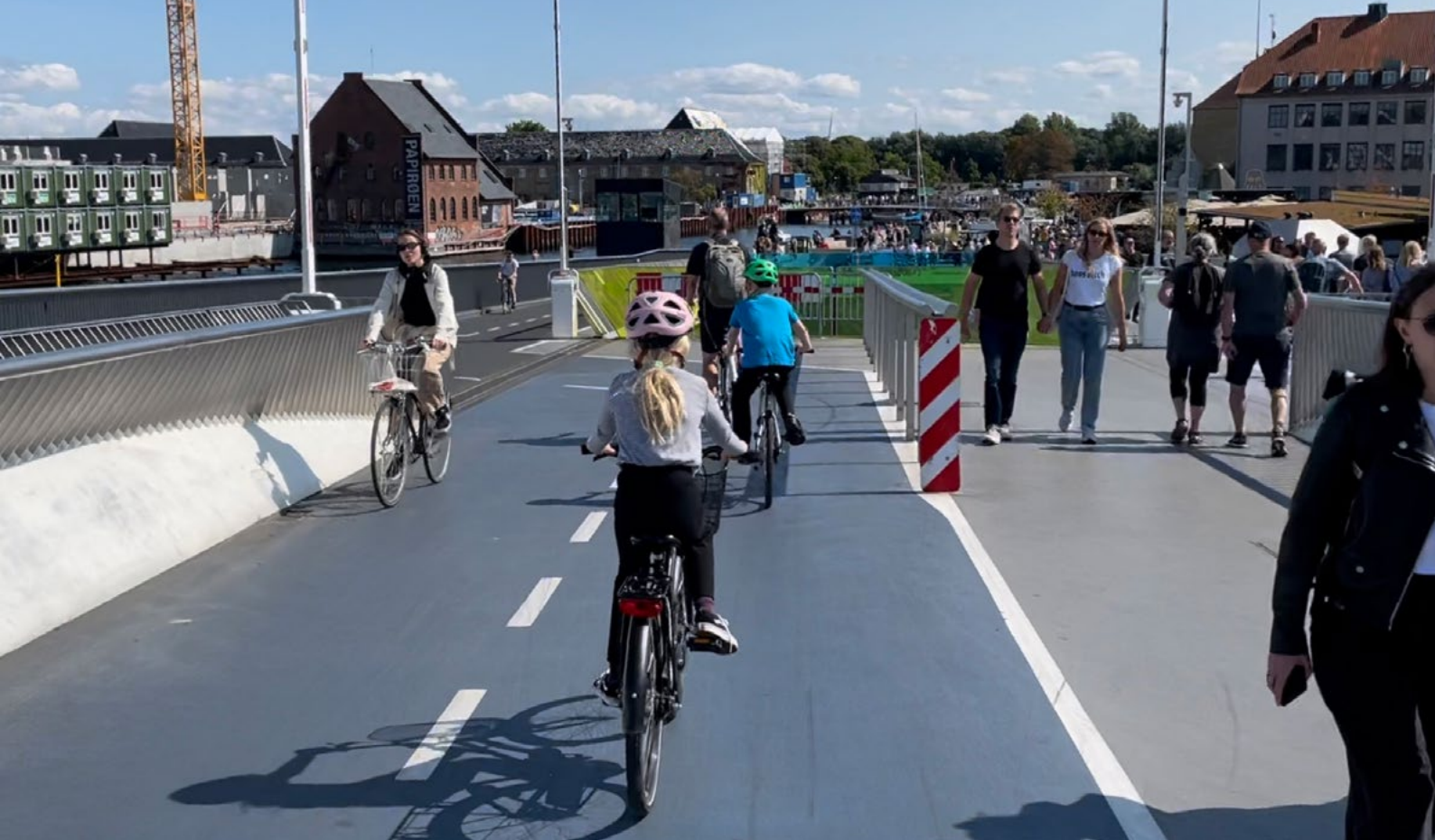
Inderhavnsbroen. Kładka pieszo-rowerowa w turystycznej części Kopenhagi
